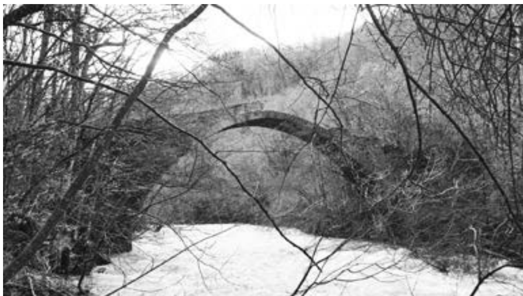
Fig. 3. Il ponte di Castrola fotografato nel 2018 (foto di Mauro Filippini).
