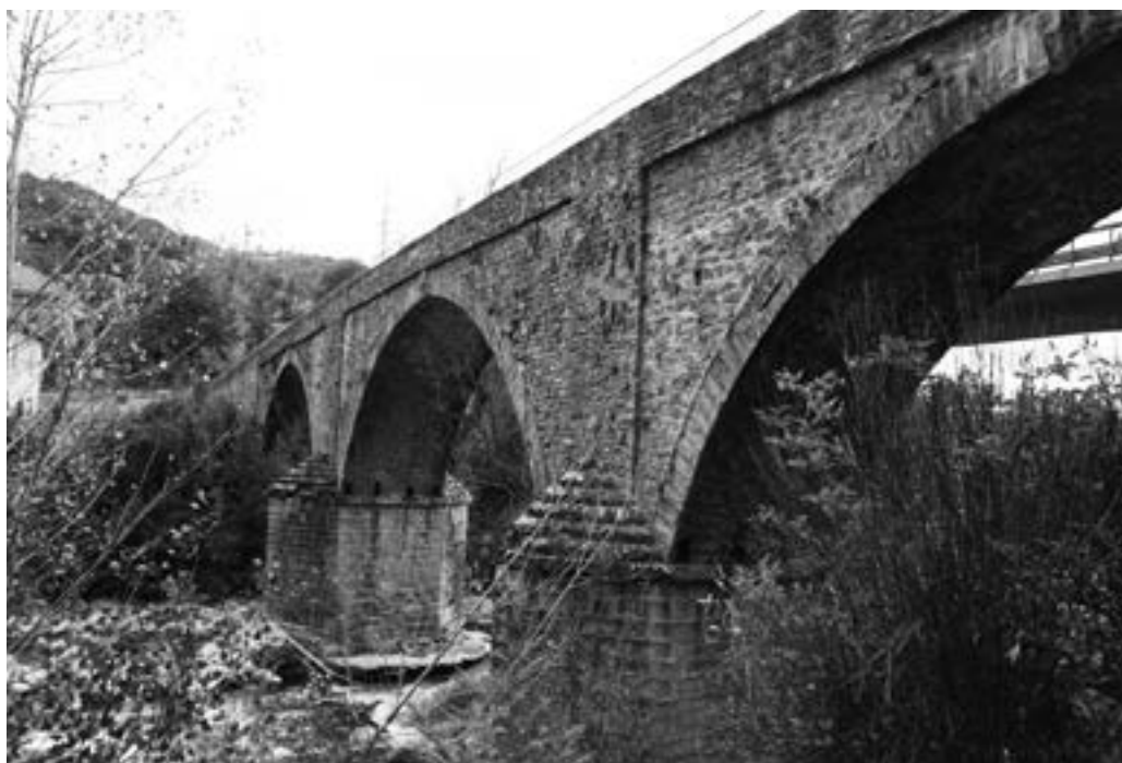
Fig. 10. Ponte dei Leoni di Strettara sul torrente Scoltenna a Montecreto (MO (foto di Mauro Filippini).
