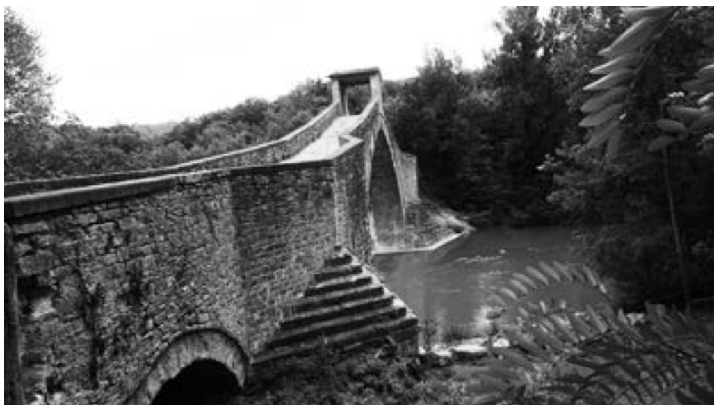
Fig. 14. Ponte di Olina dove è visibile un allargamento della sede (foto di Mauro Filippini).
