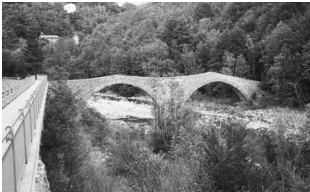
Fig. 8. Ponte della Fola sul torrente Scoltenna nel modenese fra Pievepelago e Riolunato (foto di Mauro Filippini).
