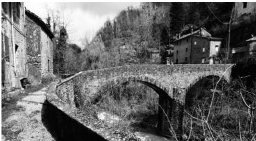
Fig. 5. Ponte di Biagioni sul fiume Reno visto dal paese di Biagioni (comune Alto Reno Terme [BO]) (foto di Mauro Filippini).
