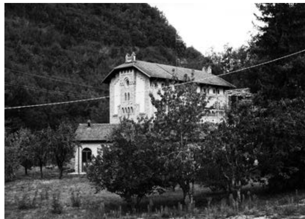
Fig. 12. Centrale idroelettrica di Strettara (foto di Mauro Filippini).
