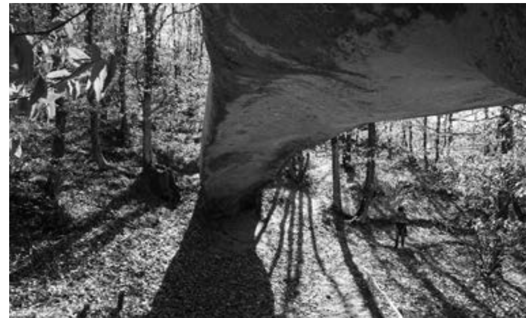
Fig. 17. Ponte d'Ercole o Ponte del Diavolo visto da sotto (foto di Mauro Filippini).
