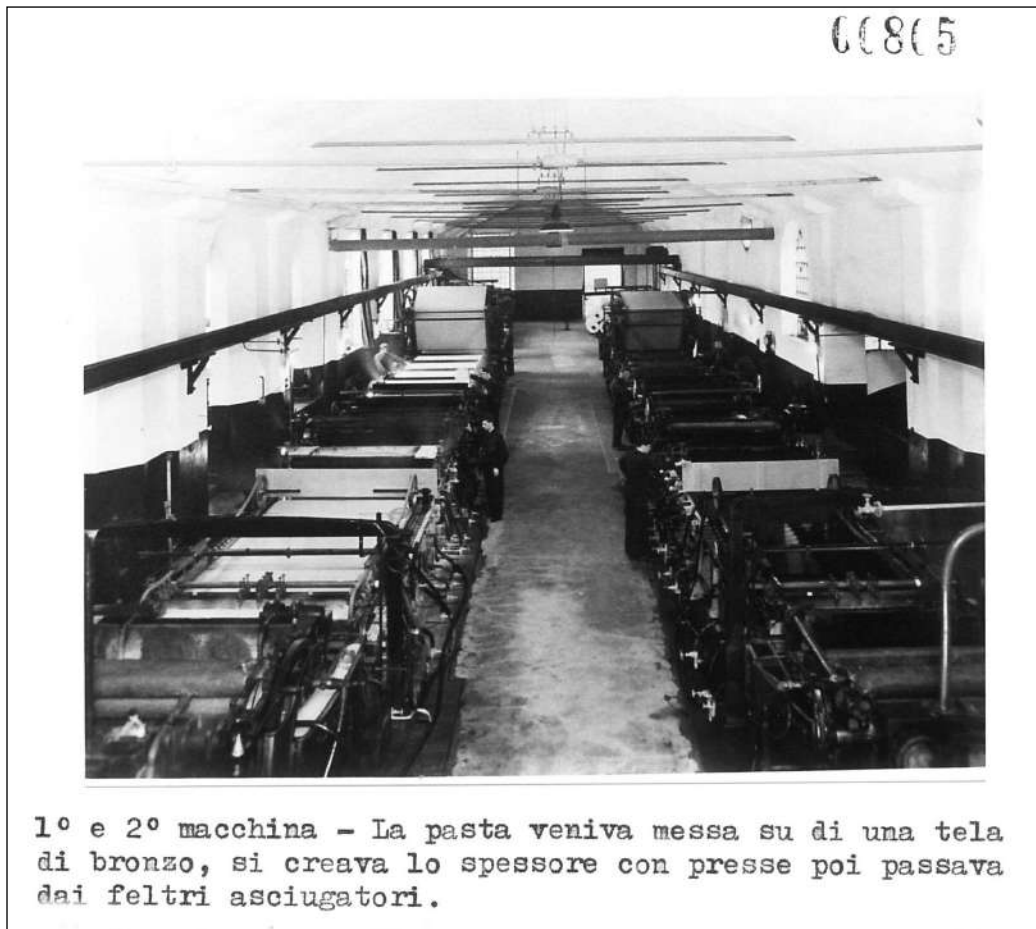
Fig.4. Il locale e le macchine continue con cui si lavorava la pasta di stracci, 1930 circa (Archivio Ugo Guidoreni).
