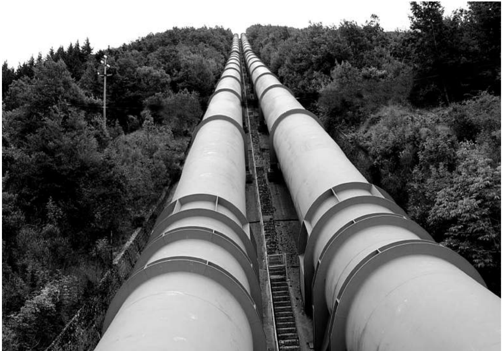
Fig.4. Le condotte forzate che portano l'acqua alla centrale di Bargi hanno un diametro che varia da 3,60 a 4,40 m per una portata fino a 104,6 m 3 /sec (foto tratta dal web: www.progettodighe.it ).
