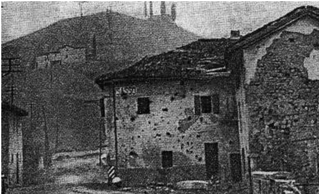
Fig.3. Le case della Tintoria nell'aprile 1945, all'indomani dell'ingresso degli alleati. Sono visibili i danni causati dai bombardamenti; la casa in primo piano verrà poi demolita (collezione Alberto Cavalieri, da "Sasso & Dintorni" quindicesima edizione, 2010).
