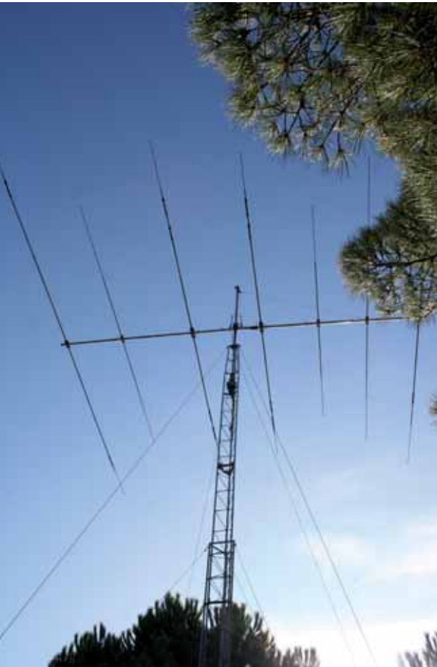
Fig. 3. La grande antenna direttiva a sette elementi installata davanti alla casa della signora Carla Cenacchi a Rasiglio (foto Franca Foresti)
