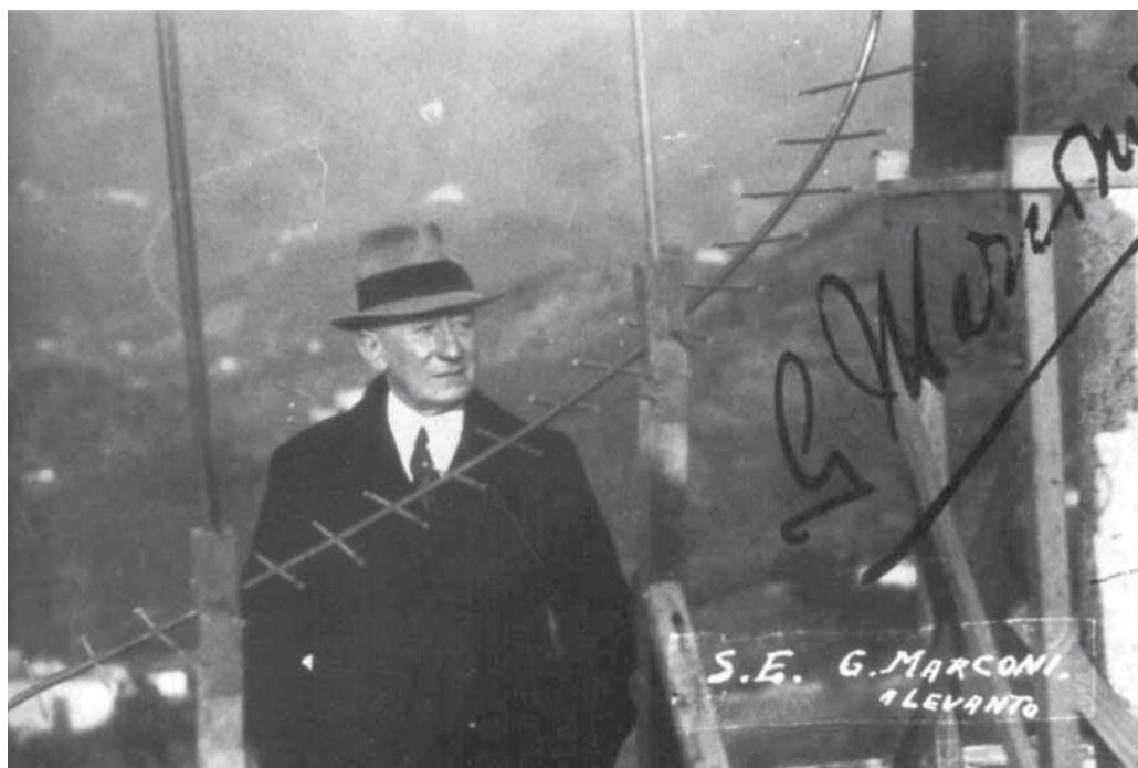
24 - Guglielmo Marconi in una foto autografa a bordo dell'Elettra nel porto di Levanto nel 1935. In primo piano l'antenna direttiva a lisca di pesce per la trasmissione con microonde (Archivio Fondazione Guglielmo Marconi)
