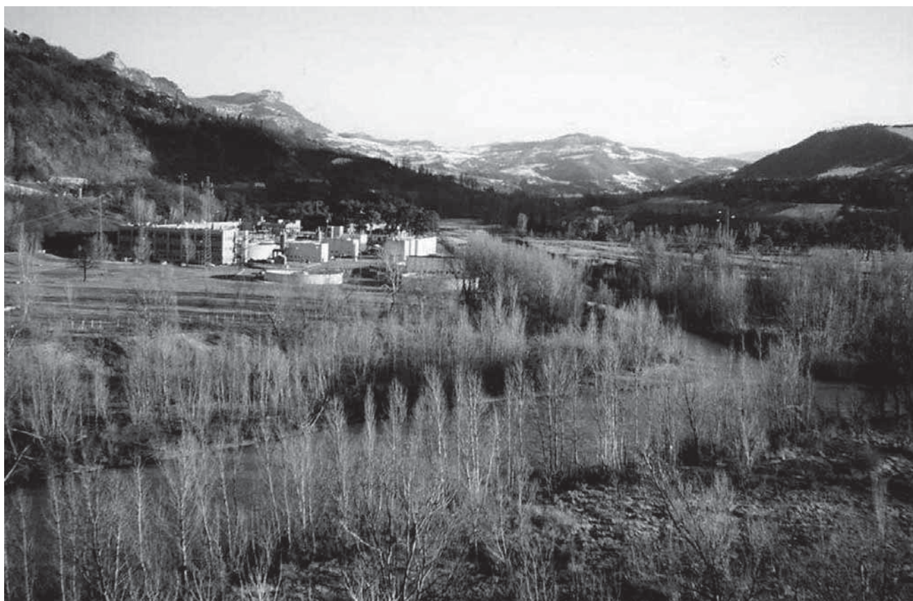
Fig.4. Nella foto è visibile l'impianto della "Centrale di Potabilizzazione Val di Setta", posto sulla sponda destra del Setta poco prima della confluenza delle sue acque in quelle del fiume Reno, ai piedi della Rupe di Sasso Marconi. Qui si trova l'imbocco dell'Acquedotto Romano (foto Paolo Michellini)
