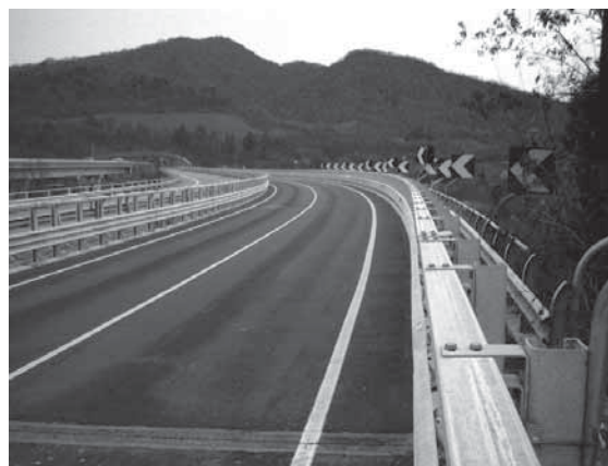
FIG. 9 - 30 giugno 2009 : apertura della nuova Porrettana. Apre finalmente la nuova strada a scorrimento veloce destinata a sostituire la storica via Porrettana. Nella foto il viadotto sul Reno (foto Enzo Chiarullo)
