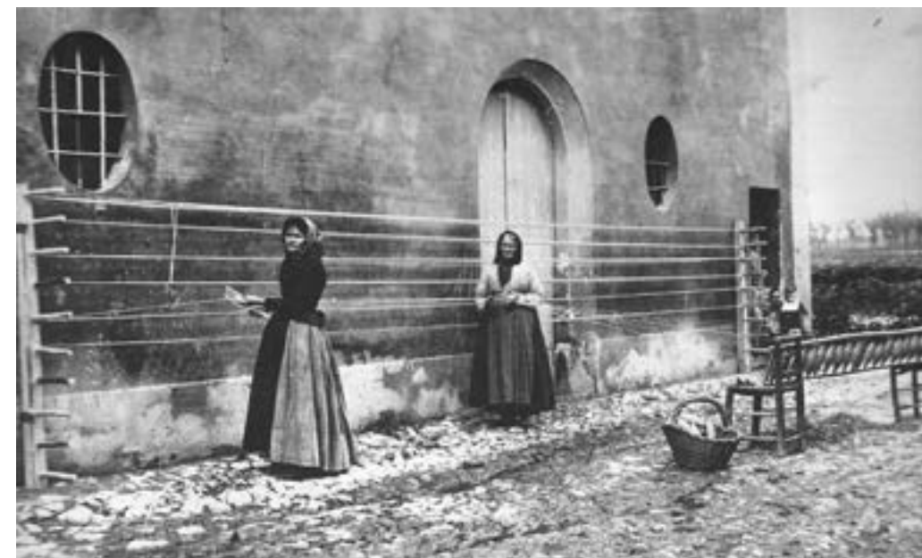
Fig.29. Fase iniziale dell'operazione dell'orditura (incannatura e orditura filo di canapa, San Giovanni in Persiceto 1910, da G. PEDROCCO e P. D'ATTORE, Archeologia Industriale in Emilia Romagna e Marche, 1991 ).
