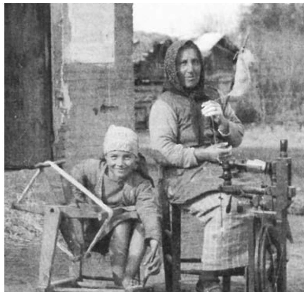
Fig.26. Filatura con rocca e filarino (in questo caso, trattandosi di stoppa, è sufficiente un sottile bastone invece della rocca per reggere il ciuffo da filare) e successiva realizzazione della matassa con l'aspo (particolare di immagine tratta da PAUL SCHEUERMEIER, Contadini del Bolognese 1923-1928 ).
