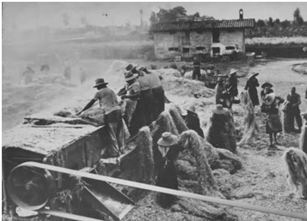
Fig. 17. Gramolatrice meccanica ('gramadóra'). (Immagine esposta al Museo della Civiltà Contadina di San Marino di Bentivoglio; foto Mauro Filippini).
