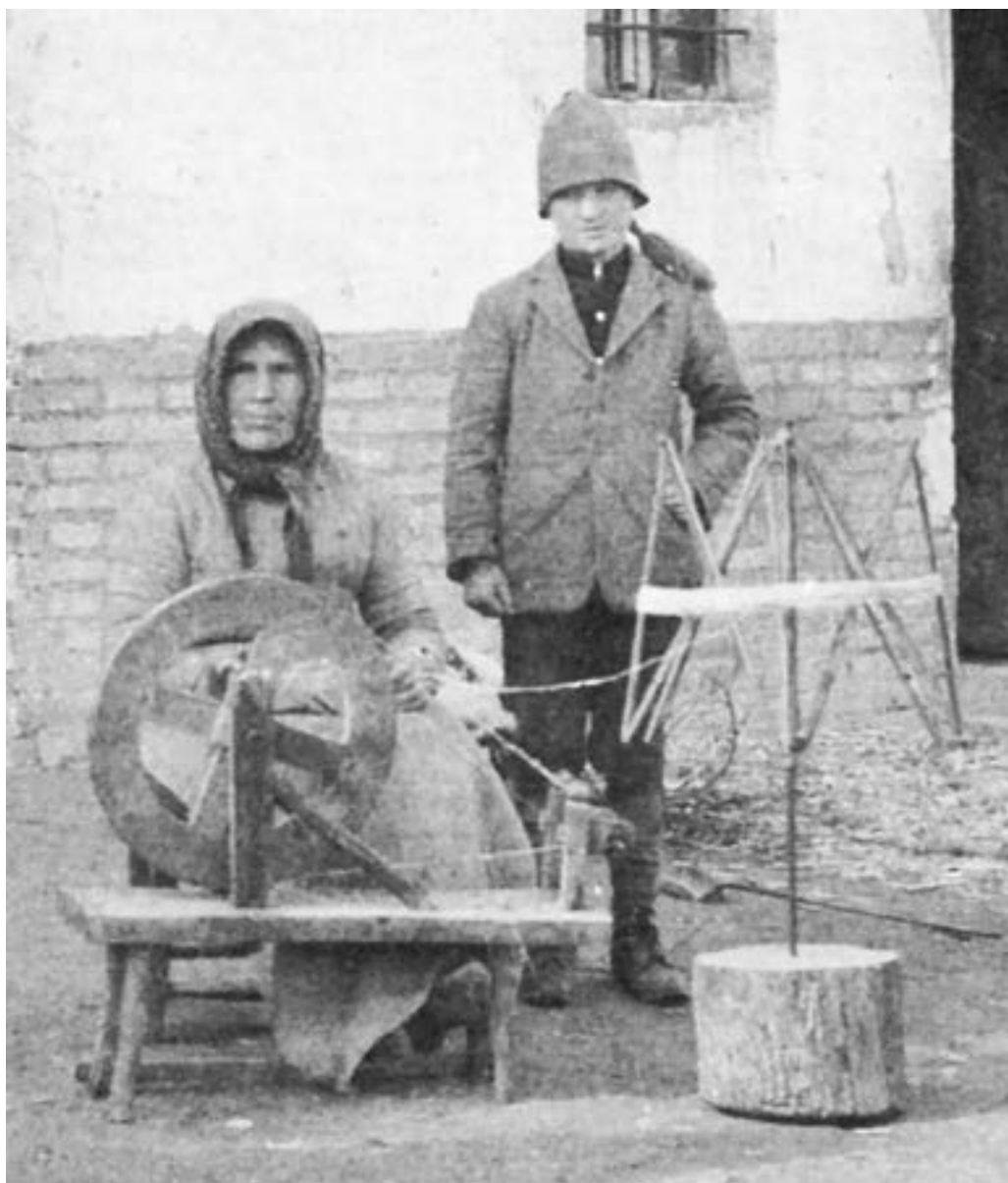
Fig.27. Dopo la lavatura, la matassa è posta sull'arcolaio per l'avvolgitura delle canne e delle cannelle per mezzo dell'incannatoio (particolare di immagine tratta da PAUL SCHEUERMEIER, Contadini del Bolognese 1923-1928 ).
