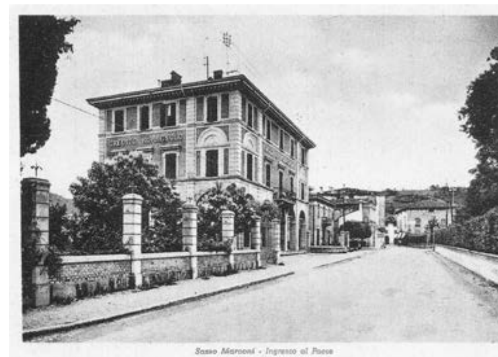
Fig. 7. Vista della Porrettana con a sinistra il fabbricato del Credito Romagnolo e poco dopo l'oratorio di Santa Apollonia. Di fronte, sulla destra, il cancello di ingresso a Villa Achillini (cartolina Edizioni Fabbriani tratta dal volume "Sasso e Marconi nelle cartoline d'epoca" a cura di Giuseppe dall'Olio, 2006).
