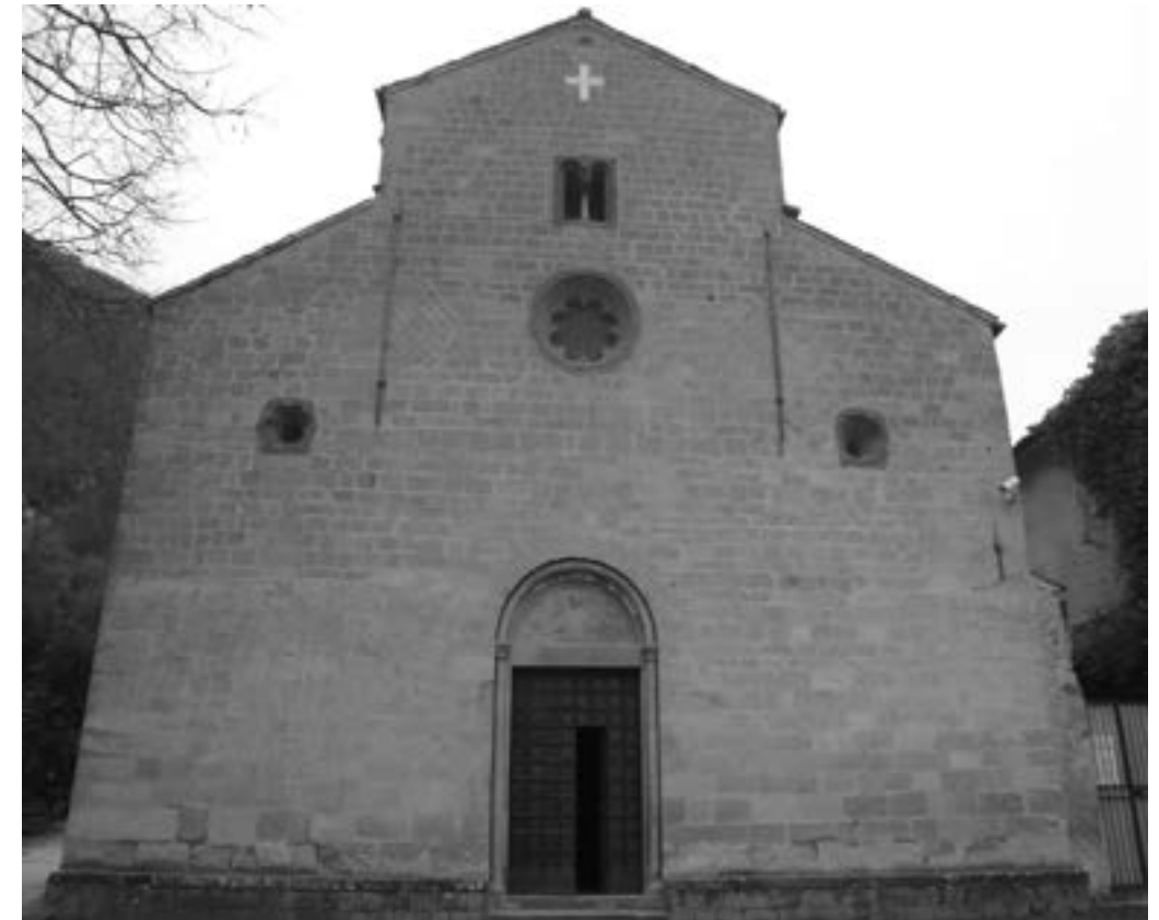
Fig. 4. La facciata di San Lorenzo dopo i restauri (foto Matteo Tirtei).
