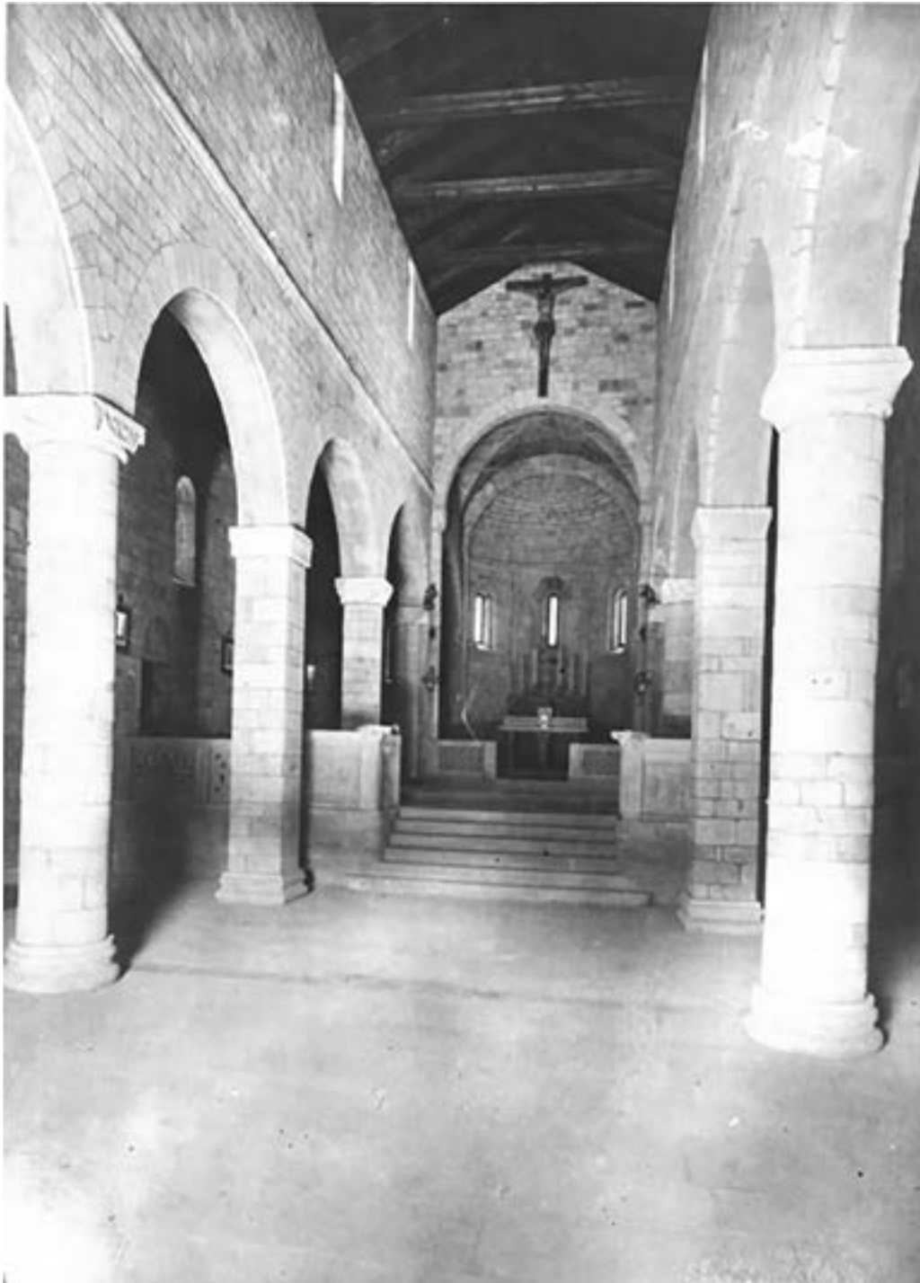
Fig. 3. Foto dell'interno della pieve di Panico dopo i restauri (dall'archivio Fondazione Cassa di Risparmio Bologna - Genius Bononiae, Fondo Fantini - FANT 0737).
