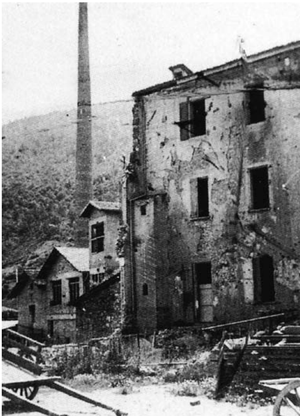
Fig.2. La cartiera IRIS a Lama di Reno dopo il bombardamento alleato del 27 novembre 1943 (da "Prima degli unni a Marzabotto, Monzuno, Grizzana, di Luigi Arbizzani).
