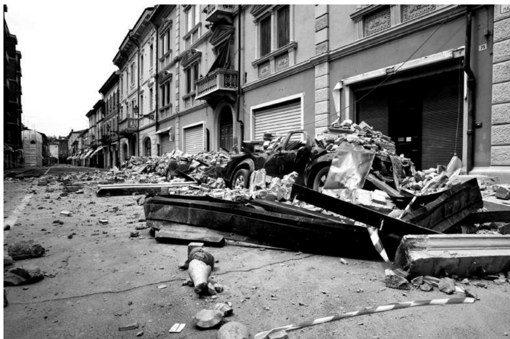
Fig.3. Una strada del comune di Concordia sulla Secchia sconvolta dal sisma del 20 maggio (foto tratta dal web: www.blitzquotidiano.it ).
