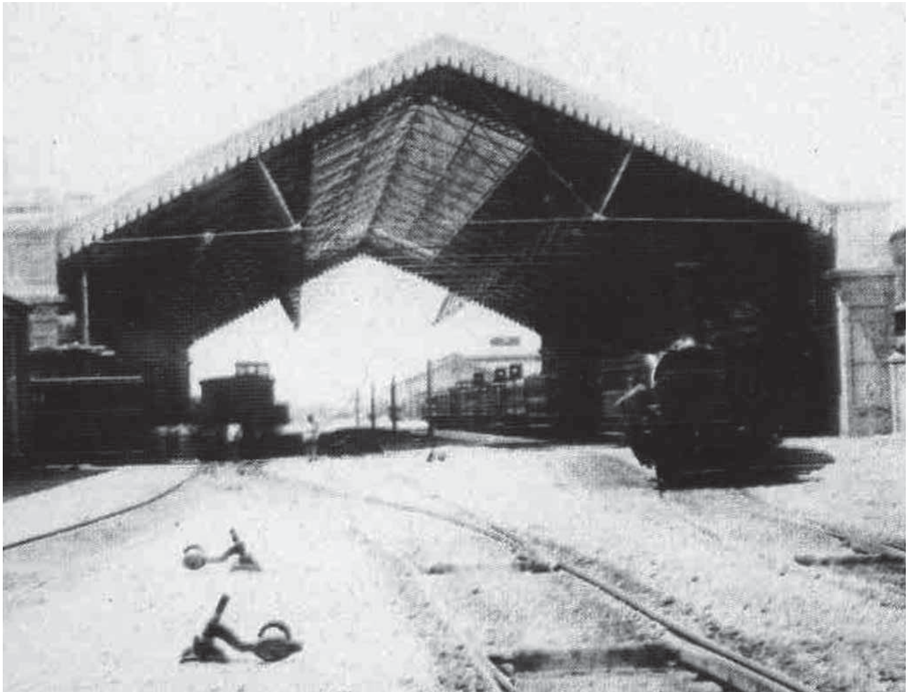
Fig. 3. Il piazzale dei binari della stazione centrale di Bologna con la grande tettoia metallica (foto tratta dal volume “Ferrovie Italiane-150 anni di storia” Editori Riuniti, 1988)
