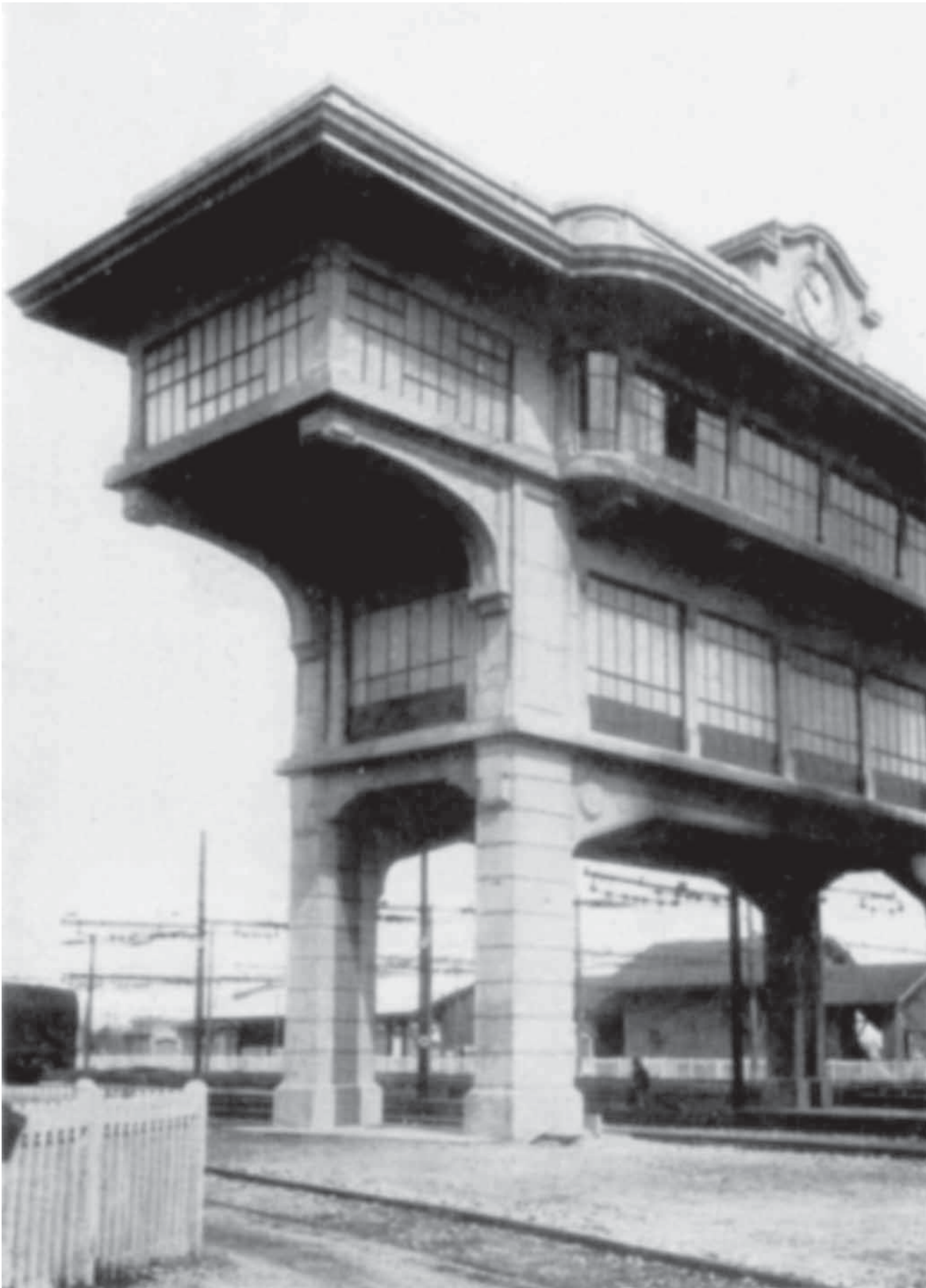
Fig. 4. Una delle cabine di controllo del traffico tramite apparati elettrici (foto tratta dal volume “Cinquantenario delle Ferrovie dello Stato 1905-1955” Ed. CIFI Ristampato da Ed. DueGi nel 2002)
