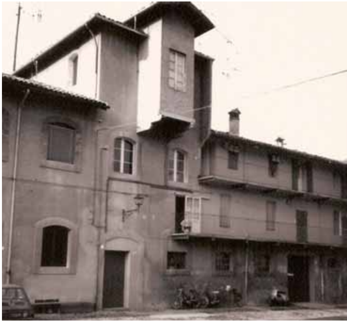
Fig. 6. Il prospetto della Cartiera viene alterato dalla sovrapposizione degli elementi architettonici che individuano i nuovi alloggi per gli operai, con tipologia a ballatoio e bagno comune esterno, realizzati nella prima metà del Novecento. (foto di Sabrina Carlini e Michaela D'Astuto)
