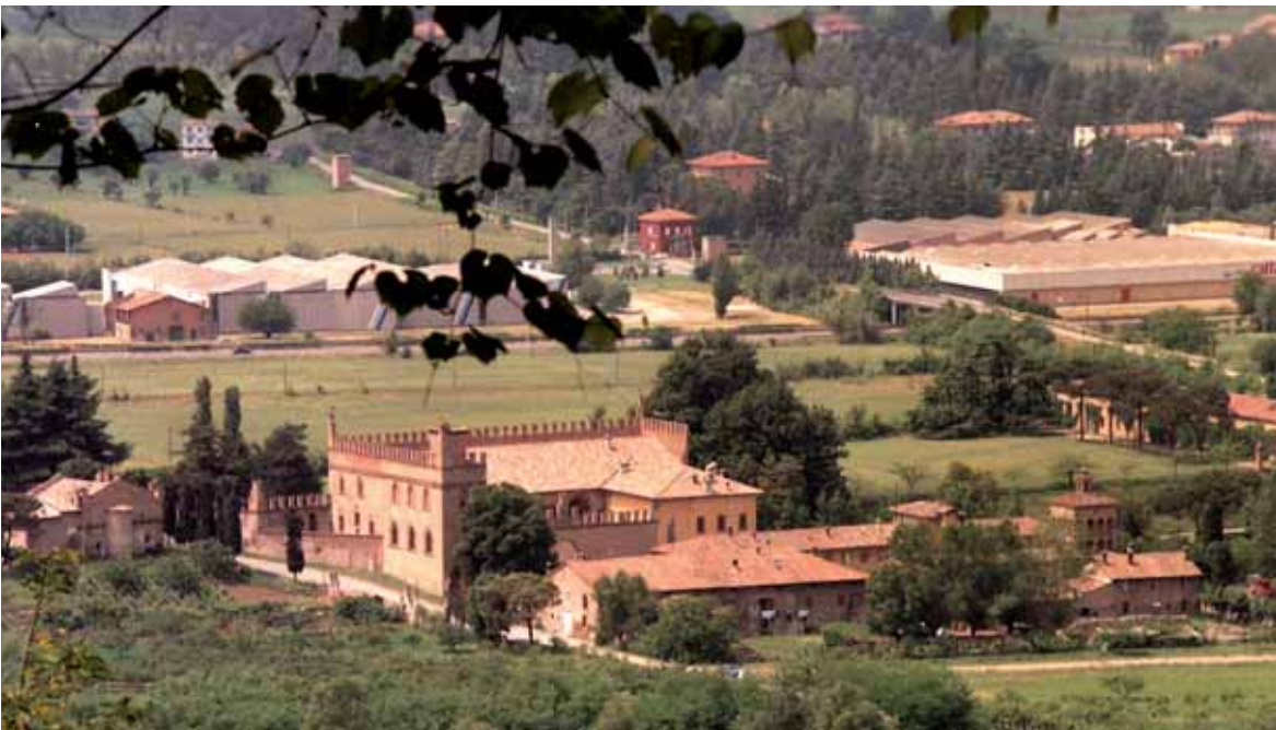
Fig. 4. L'intorno di Palazzo de' Rossi. Vista del Castello e attiguo Borgo, verso la Strada Porrettana. L'arteria autostradale e la ferrovia separano il complesso architettonico dal territorio limitrofo, dove si insedia una urbanizzazione di tipo industriale. (foto di Sabrina Carlini e Michaela D'Astuto)
