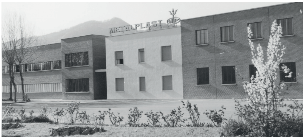
Fig. 22. Ampliamento dello stabilimento con costruzione della nuova ala adibita all'abitazione del custode (la parte sottostante l'insegna) e il magazzino supplementare (alla sua destra) (Foto Famiglia Mazzoli).
